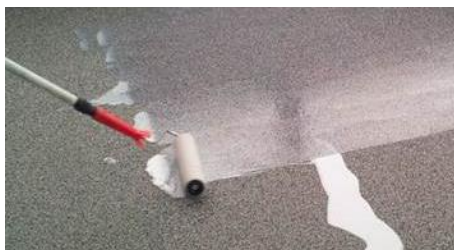
Abb. 3 und 4: Auftragen der Versiegelung
