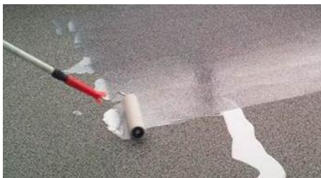
Fig. 3 et 4 : Application du produit d'étanchéité
