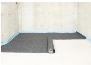
2. **DAMTEC® estra** Dämmunterlage voll-flächig im Raum auslegen und etwas größer zuschneiden. Den Belag 1 Tag (mind. 24 Stunden) entspannen und akklimatisieren lassen.
