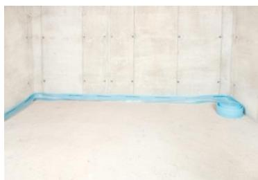
1. Untergrund gründlich abfegen. Mörtelreste entfernen. Zur Vermeidung von Schallbrücken zu allen aufgehenden Bauteilen, wie Wänden, Rohrleitungen und anderen Randdämmstreifen verlegen.
