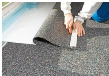
3. Zum Zuschneiden kann ein Cutter Messer und eine Anlegeschiene verwendet werden.
