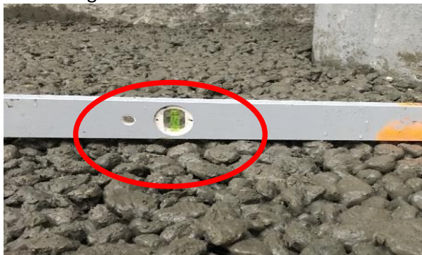
Oberfläche muss frei von scharfen Kanten sein
