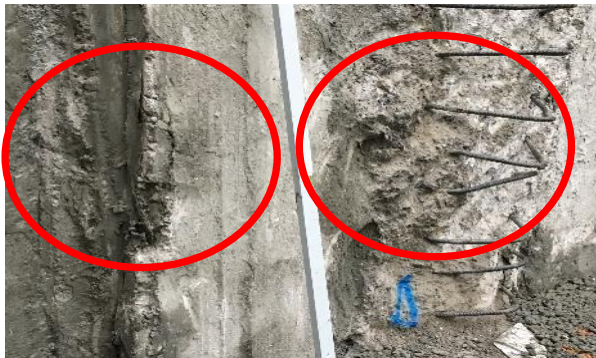
Oberfläche muss frei von scharfen Kanten sein
