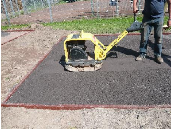
Ausgleichsschicht standfest verdichten
