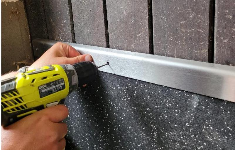
Abhängig von der vorhandenen Boxenwandqualität, Holzwand oder Betonwand wird die entsprechende Senkkopfschraube eingesetzt, und die Fliese mit der Edelstahlreifassung im Abstand von 25cm fixiert.
