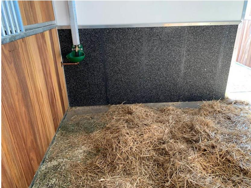
Trennkanten der Edelstahleinfassung müssen entgratet werden, um die Verletzungsgefahr für die Pferde zu verhindern.
