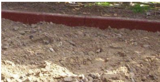
Unterbau aus Schotter 0-32 mm
