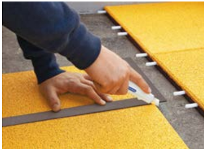
Abb. 6: Zuschneiden mit Teppichmesser
