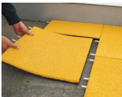
Abb. 1: Verlegung mit T-Fuge
