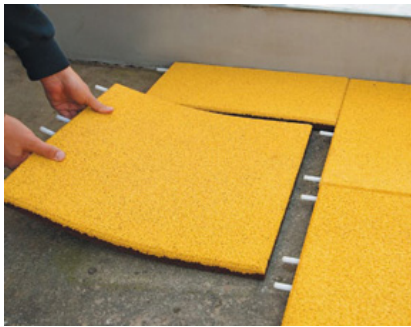
Abb. 1: Verlegung mit T-Fuge
