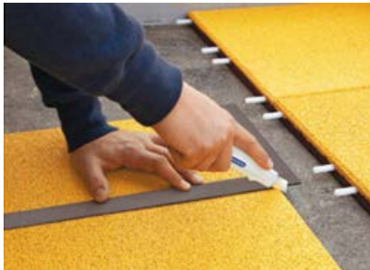
Abb. 6: Zuschneiden mit Teppichmesser
