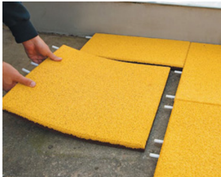
Illustration 1: Pose avec joint en T
