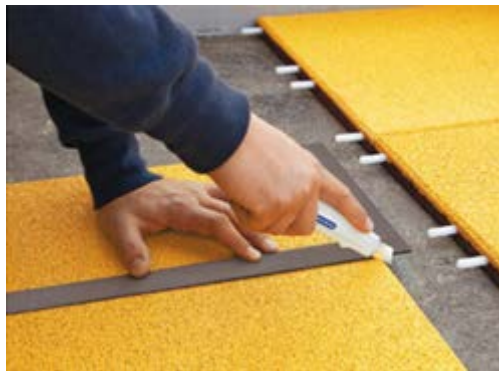
Illustration 6: Découper avec une scie sauteuse à vitesse lente ou couteau à tapis
