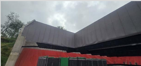
Matte mit Schraubleisten an der Wand befestigt
