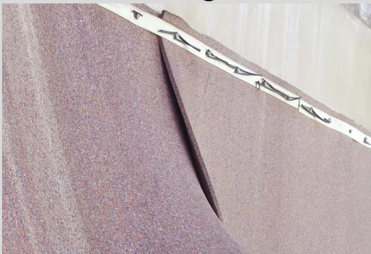
Matte mit Schraubleisten an der Wand befestigt
