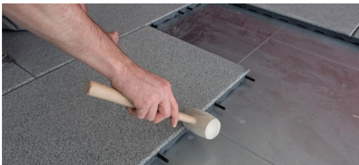
Schließen von Lücken mit einem Hammer
