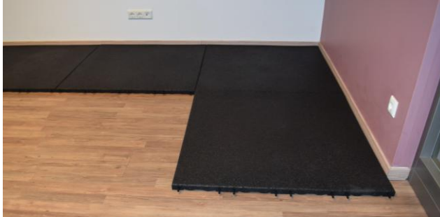
Die zweite Reihe mit den Platten genauso beginnen und fortfahren; Platte neben Platte legen
