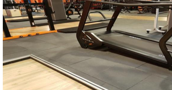
Verwendung von Rand- und Randeckprofilen; Einfassung aus Metall
