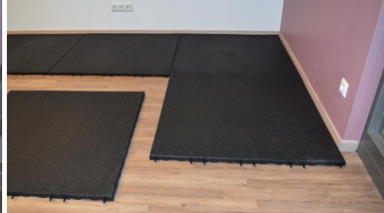
Die zweite Reihe mit den Platten genauso beginnen und fortfahren; Platte neben Platte legen
