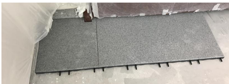
Verlegung der Platten entlang einer graden Wand mit den Steckverbindern nach vorne
