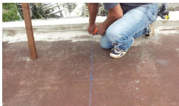
Erstellen von Kreidelinien als Verlegehilfe
