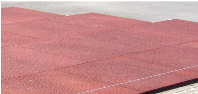
Verlegung der Platten entlang einer Randeinfassung
