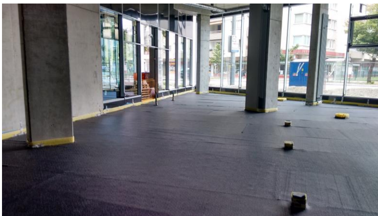
Verlegung der Elastikschicht im ganzen Raum
