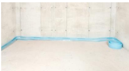
Verlegung von Randdämmstreifen
