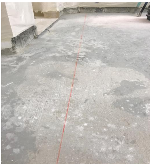
Erstellen von Kreidelinien als Verlegehilfe
