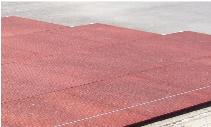
Verlegung der Platten entlang einer Randeinfassung
