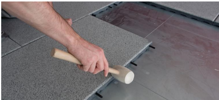
Schließen von Lücken mit einem Hammer
