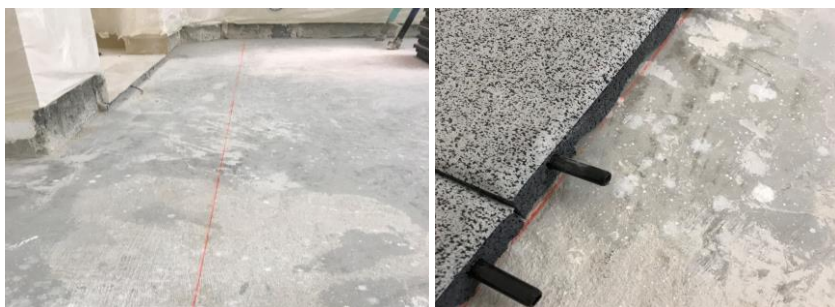
Erstellen von Kreidelinien als Verlegehilfe und verlegen entlang dieser Linie
