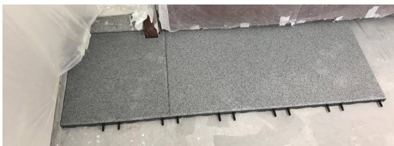
Verlegung der Platten entlang einer graden Wand mit den Steckverbindern nach vorne
