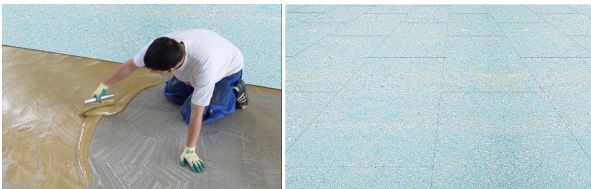
Kleberauftrag auf den sauberen Untergrund; hineinlegen der Platten in das Kleberbett
