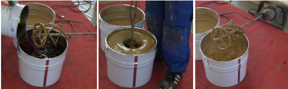
Anrühren des 2-Komponenten PU-Klebers
