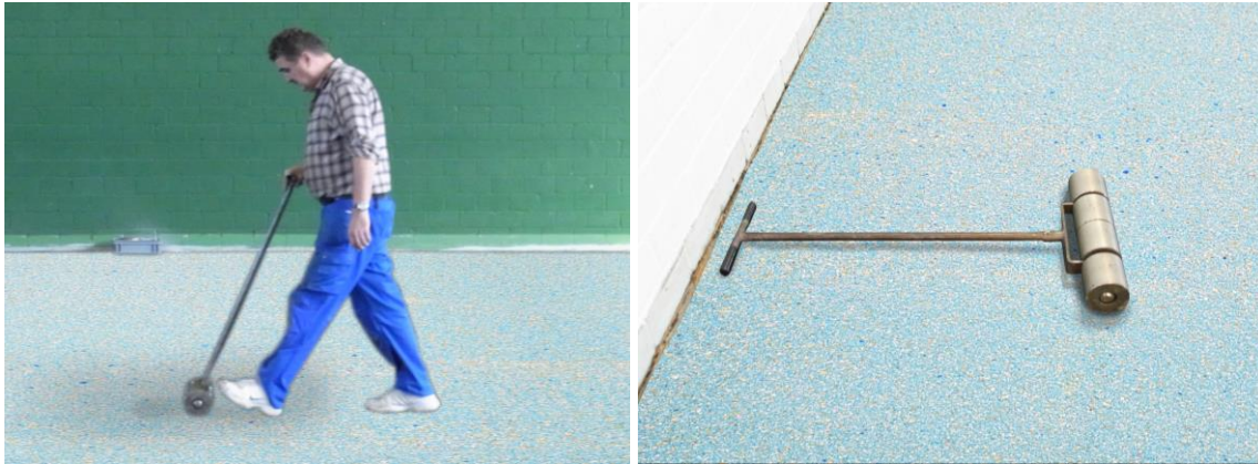
Abrollen des Belages mit einer Anpresswalze
