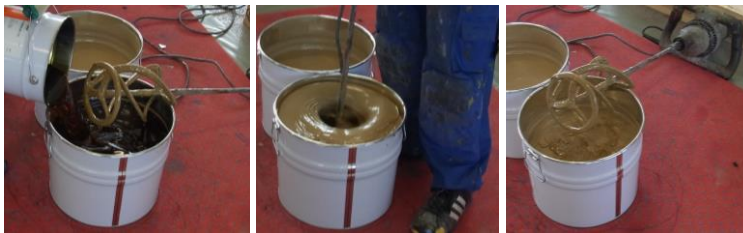
Anrühren des 2-Komponenten PU-Klebers
