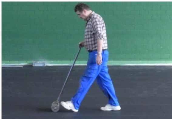
Abrollen des Belages mit einer Anpresswalze
