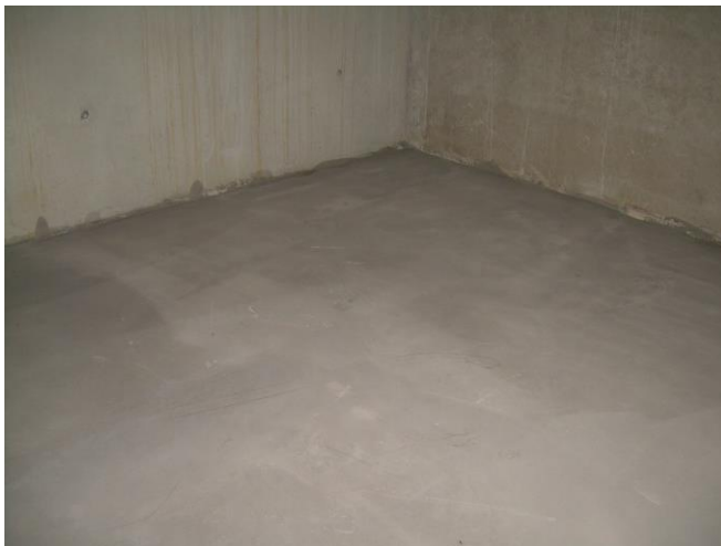
glatter, geeigneter Untergrund aus Betonestrich
