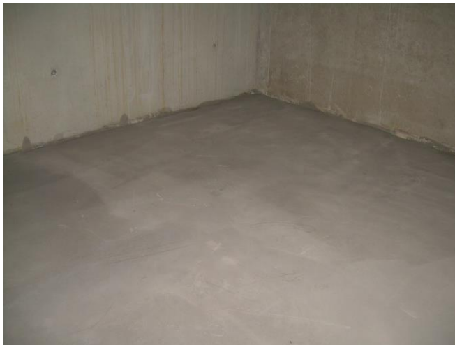
glatter, geeigneter Untergrund aus Betonestrich
