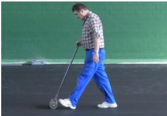
Abrollen des Belages mit einer Anpresswalze
