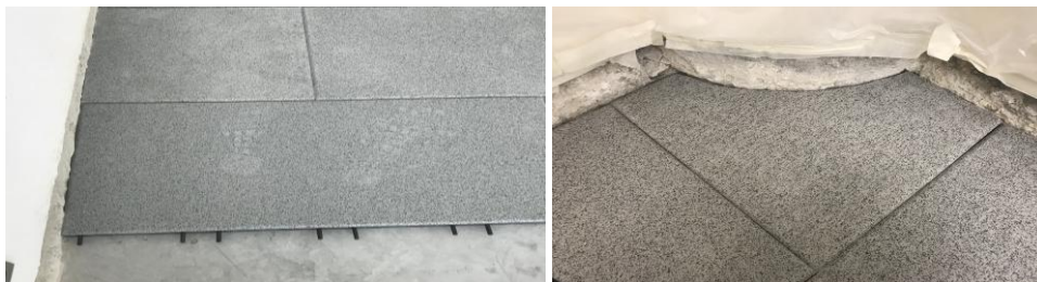
Démarrer la deuxième rangée décalée d'une demi-dalle; découper une courbe
