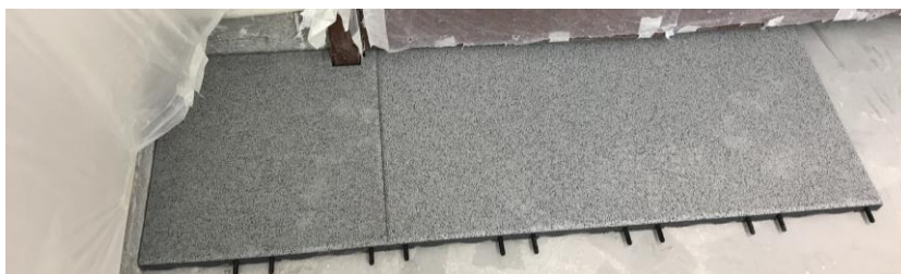
Pose des dalles le long d'un mur droit avec les connecteurs orientés vers l'avant
