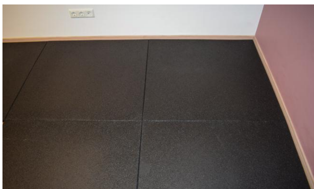
Compresser de la dalles
