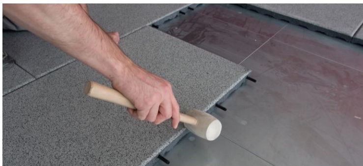
Fermez les joints avec un marteau en caoutchouc
