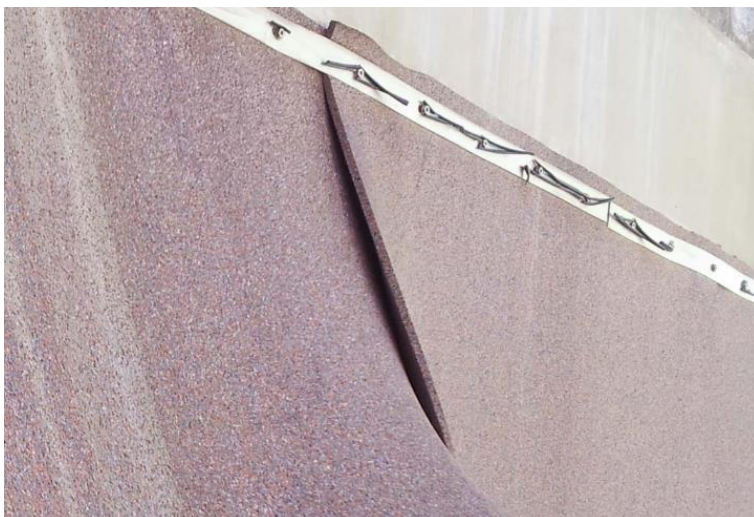
Tapis fixé au mur par des bandes de vis
