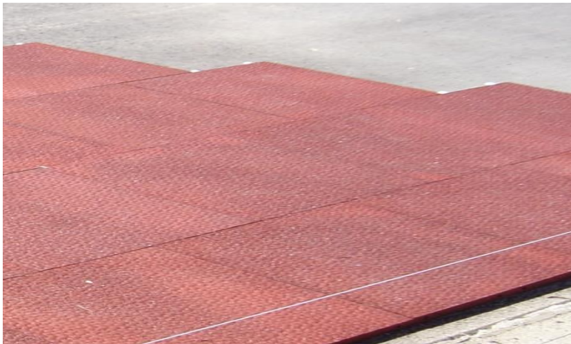
Pose des plaques le long d'un enceinte de bord
