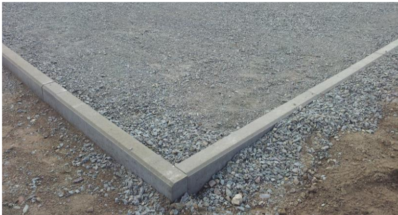
Le terrain compacté avec l'enceinte de bord
