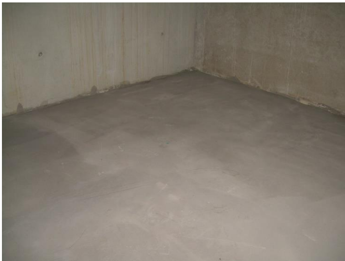
Support lisse et approprié de la chape ou béton ;
