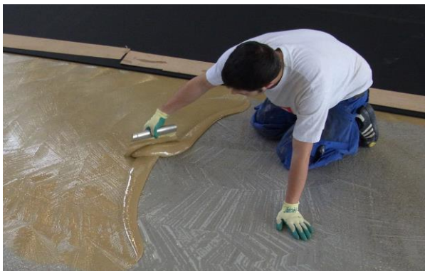
Appliquer l'adhésif sur le substrat propre;
