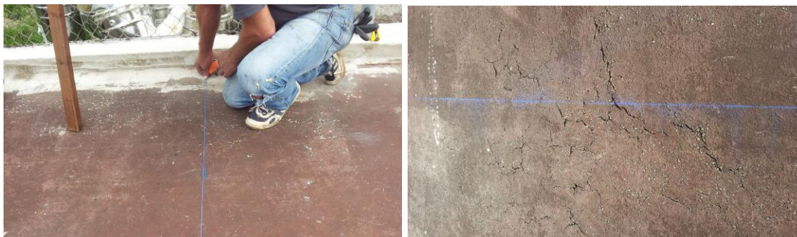
Création de lignes à la craie comme une aide pour l'installation
