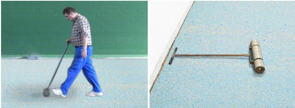
Dérouler de couche élastique à l'aide d'un rouleau de compresseur
