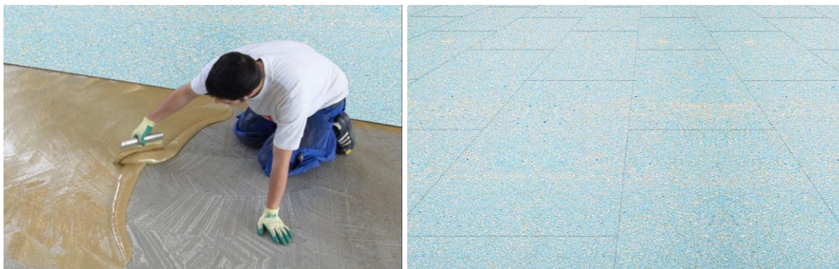
Appliquer l'adhésif sur le substrat propre; insérer les plaques dans le lit d'adhésif
