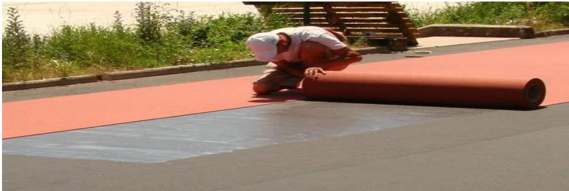
Dérouler le revêtement de surface sur la couche élastique
