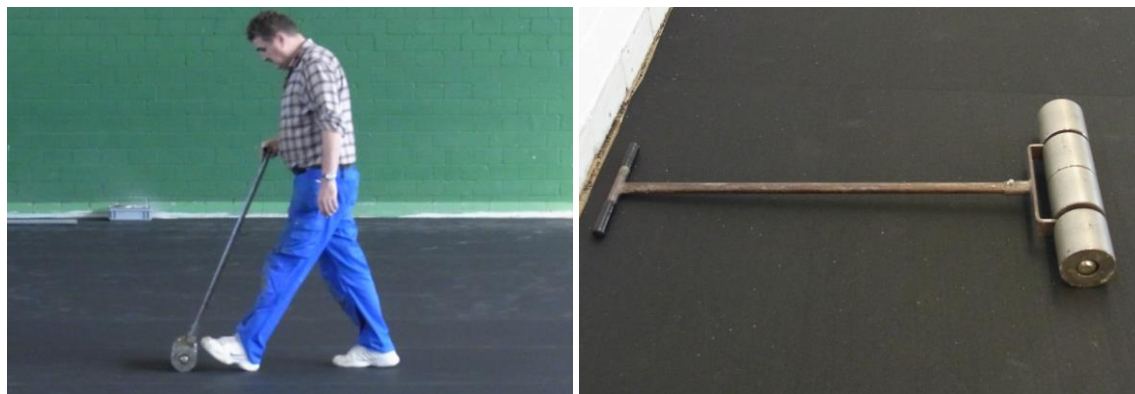
Lisser le revêtement de sol à l'aide d'un rouleau compresseur
