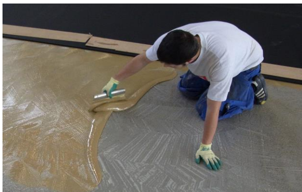
Appliquer l'adhésif sur le support propre;
