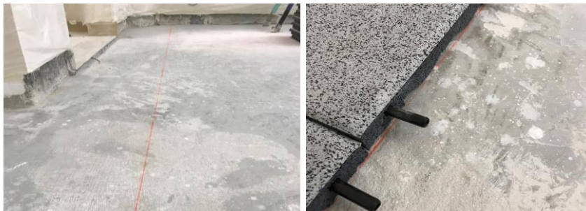
Création de lignes de craie comme aide à la pose et, pose le long de cette ligne
