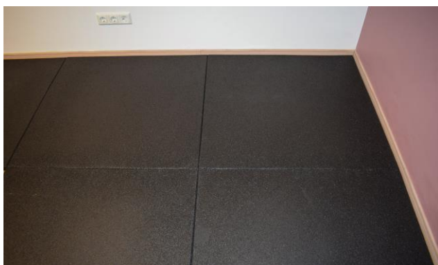
Compresser de la dalles
