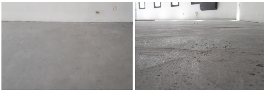
平滑で敷設に適したモルタルの下地
