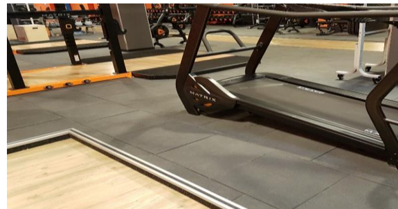
鉄製見切り材での固定。
