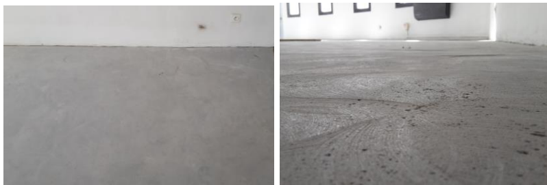
平滑で敷設に適したモルタルの下地
