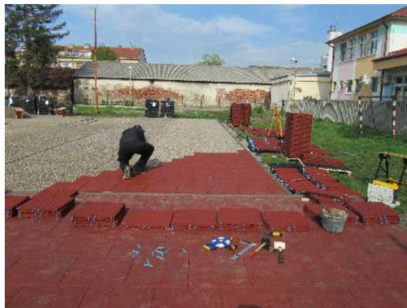
T 接続での正しい取り付け クロスジョイントでの誤った取り付け
