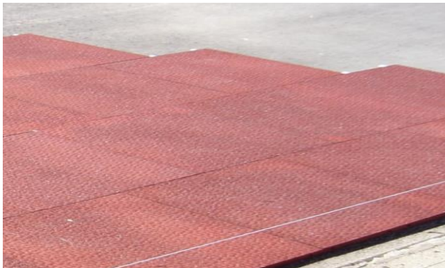
縁取りとチョークラインに沿ったタイルの設置
