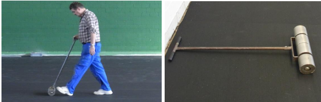
加圧ローラーによる床の圧着
