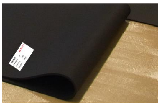
接着剤塗布面に敷設する様子
