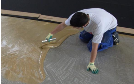
清潔な下地に接着剤を塗布する様子 接着剤塗布面に敷設する様子
