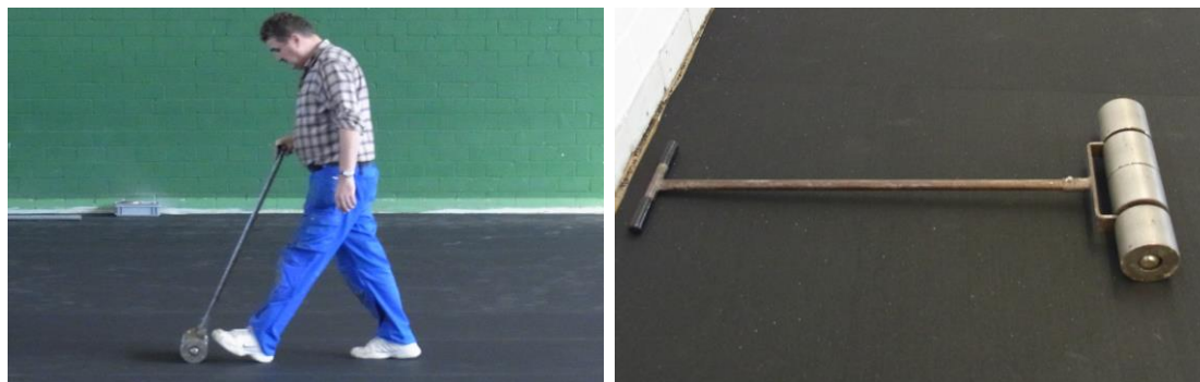
加圧ローラーによる床の圧着
