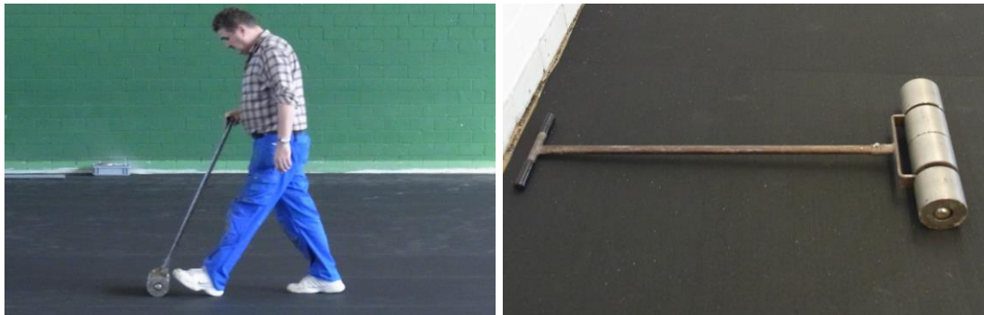
加圧ローラーによる床の圧着
