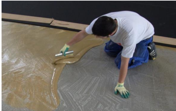
清潔な下地に接着剤を塗布する様子
