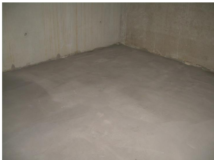
平滑で敷設に適したモルタルの下地
