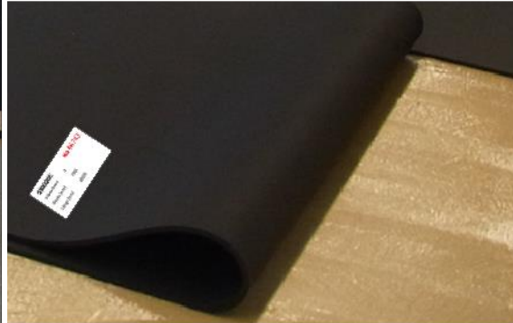
接着剤塗布面に敷設する様子
