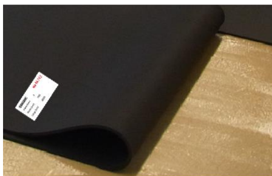
接着剤塗布面に敷設する様子
