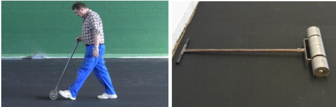
加圧ローラーによる床の圧着
