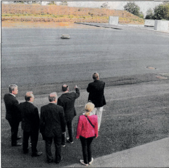
Das neue Areal, auf dem das Recyclingmaterial verarbeitet werden soll, ist fast fertig. Kraiburg lagert dorthin um, weil auch die bestehenden Hallen vergrößert werden sollen. Fotos (2): Benecke
